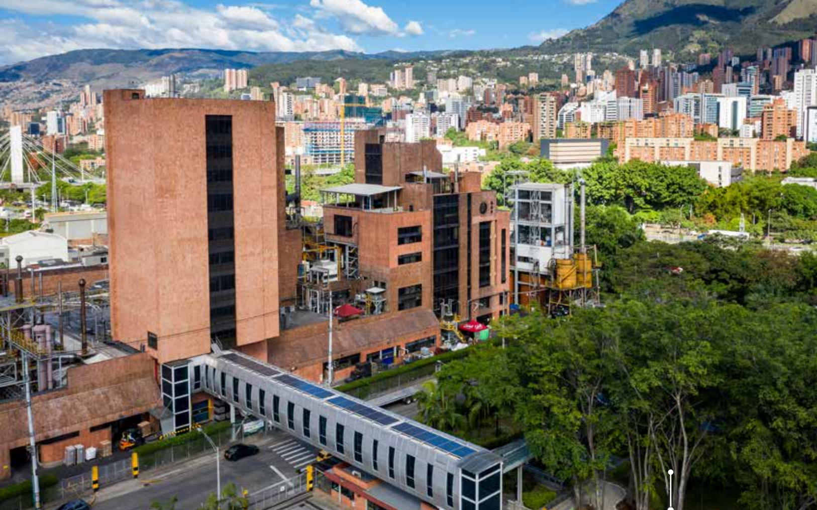
Paneles solares de la planta del Negocio Cafés, Medellín, Colombia.
